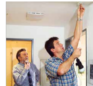
Der haustechnische Dienst bei der Arbeit.
